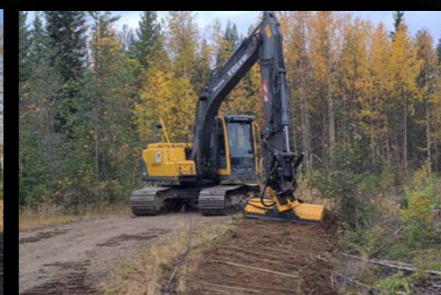
Гидравлический MC4 установленный на экскаватор
