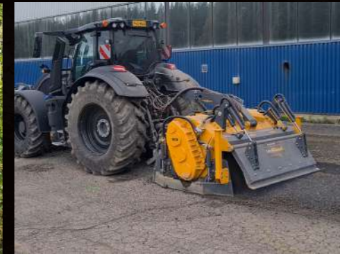
RC90 asfaltin murskaus ja kierrätys
